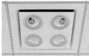
《タスクアンドアンビエント一体型吹出口》
